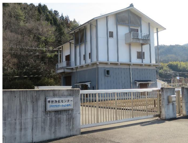
写真：甲世浄化センター
