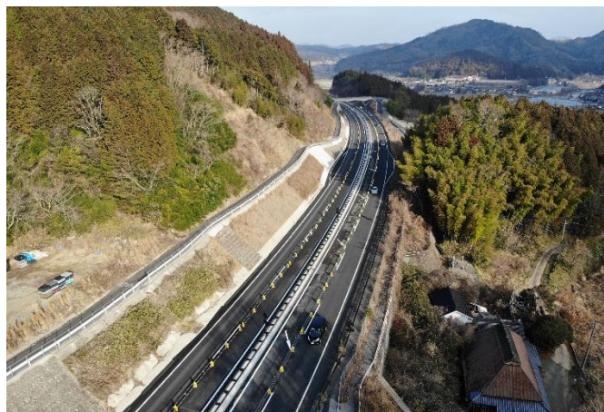
写真：4車線化した中国横断自動車道尾道松江線
