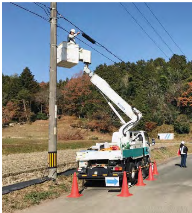
撤去が進む旧情報通信設備
