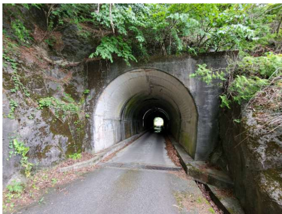
【城ヶ平トンネル】
