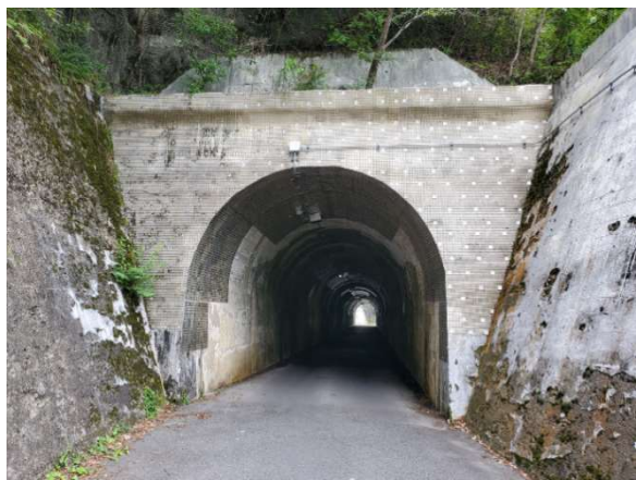
【見堂平トンネル】
