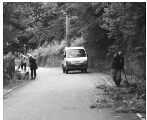
町道の草刈り作業
