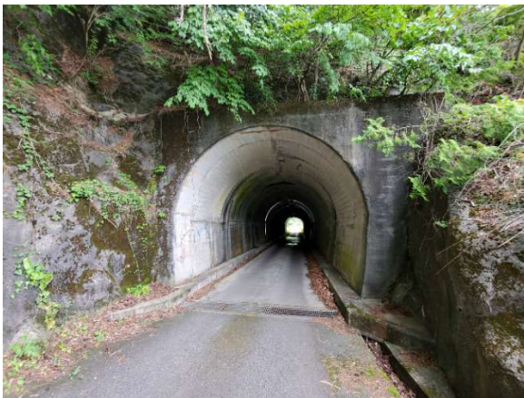
【城ヶ平トンネル】
