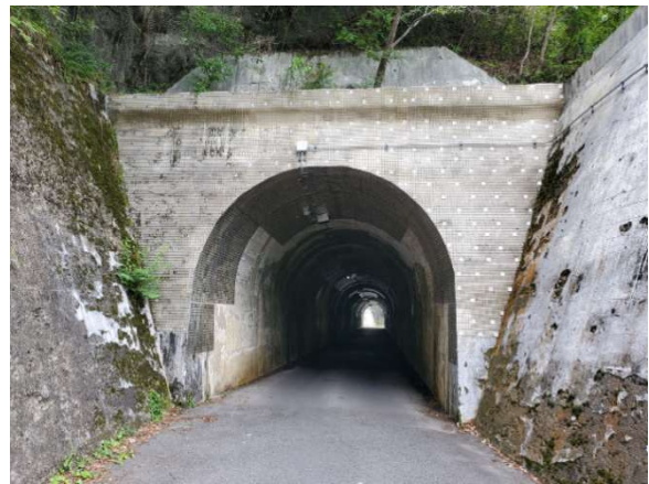
【見堂平トンネル】
