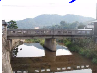
陰陽橋 L=15.7m (RC橋) 1954年架設
