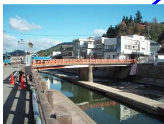
高野橋 L=27.3m (鋼橋) 1964年架設
