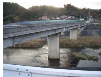
川塚大橋 L=103.7m (PC橋) 1991年架設
