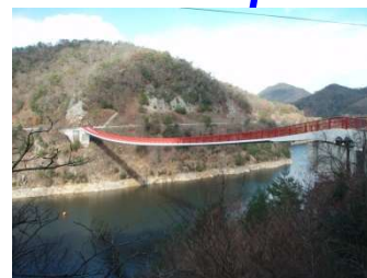
夢吊橋 L=172.6m (PC橋) 1996年架設
