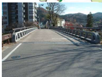
榎橋 L=44.9m (RC橋) 1958年架設
