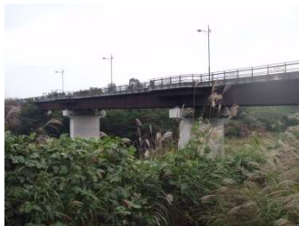
香遊大橋 L=130m (鋼橋) 1999年架設
