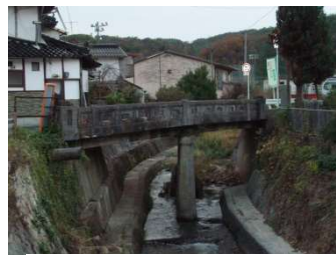
木梨橋 L=12.9m (RC橋) 1935年架設
