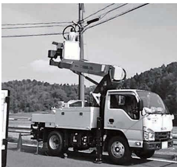
光ファイバケーブル敷設工事
