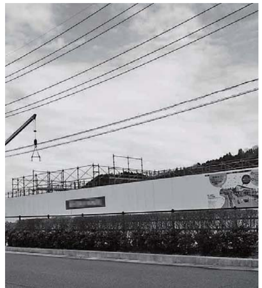
建設が進むマリオットホテル
