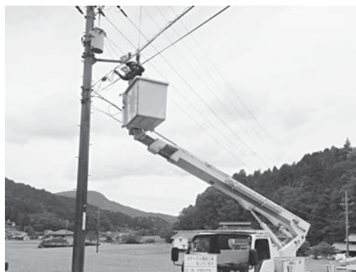
現場工事の様子
