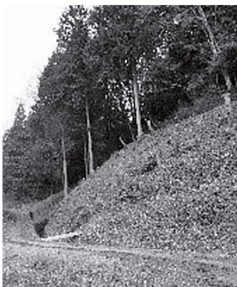
施工後のバッファゾーン
