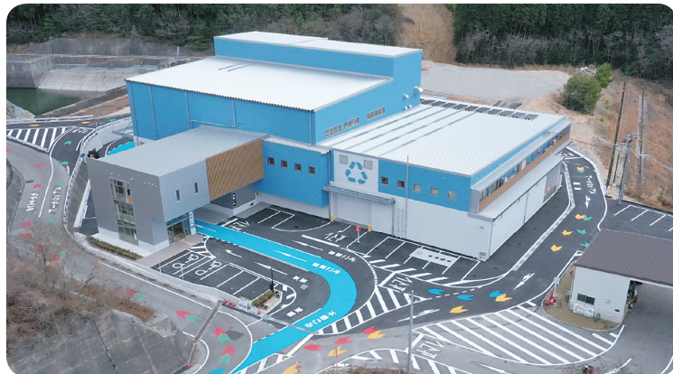
三原広域市町村圏事務組合 不燃物処理工場
