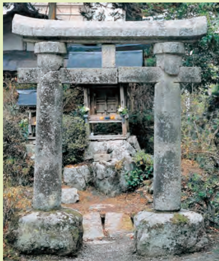
▲石造栗島神社鳥居 (県重文) 安楽院の守護神栗島神社の石鳥居。高さ2.18m。柱のころびのない古式のもので、左の柱には康暦2年(1380)の銘がある。銘入りの古鳥居としては国内有数。南北朝時代。(大字甲山◎No.43)
