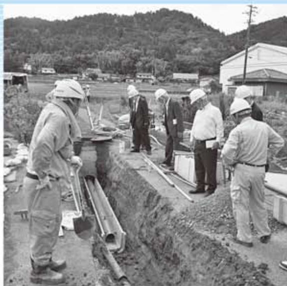
下水道の開削工法工事
