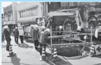
下水道工事現場
