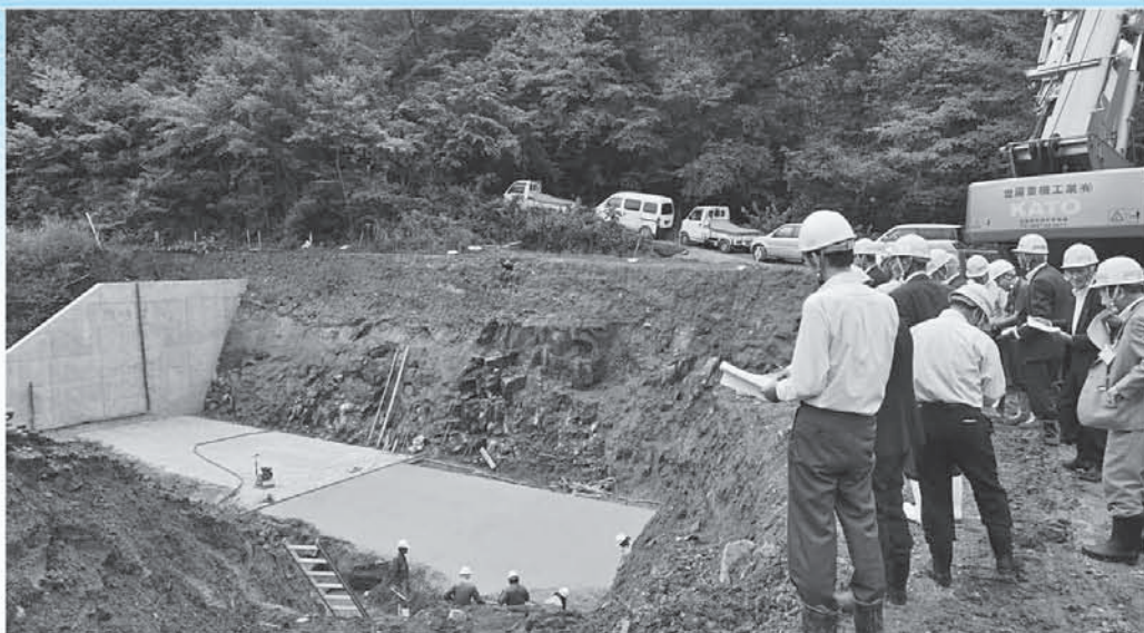
神崎大池改修工事
