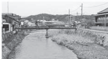
管理要望された 上の橋
