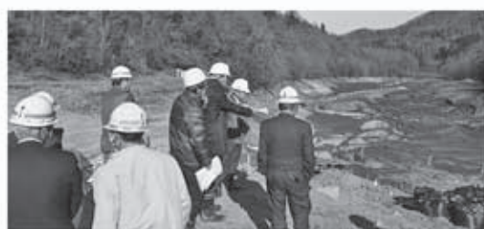
神崎大池堤体改修工事 現地視察
