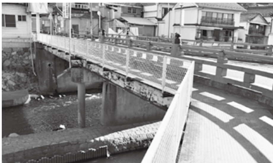
老朽化対策として修繕予定の高野橋
