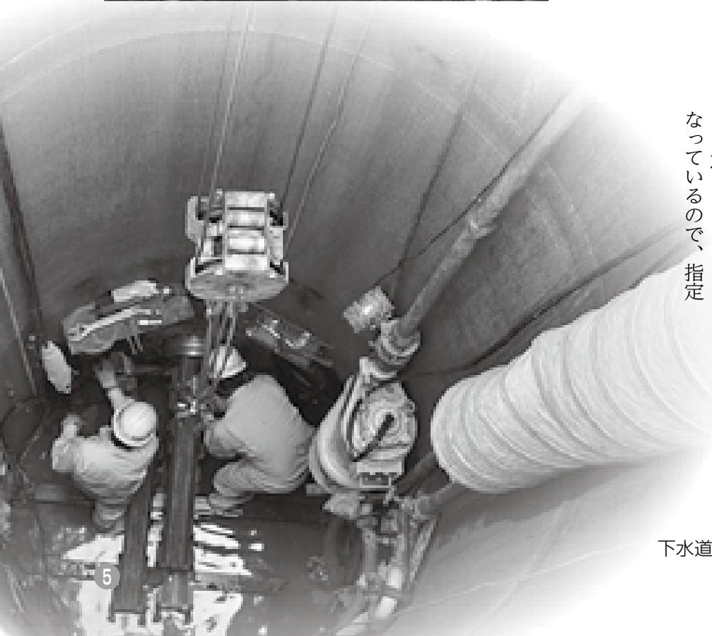
下水道推進工法工事現場
