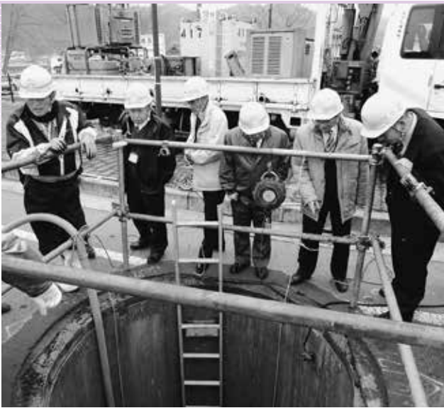
下水道工事現地調査
