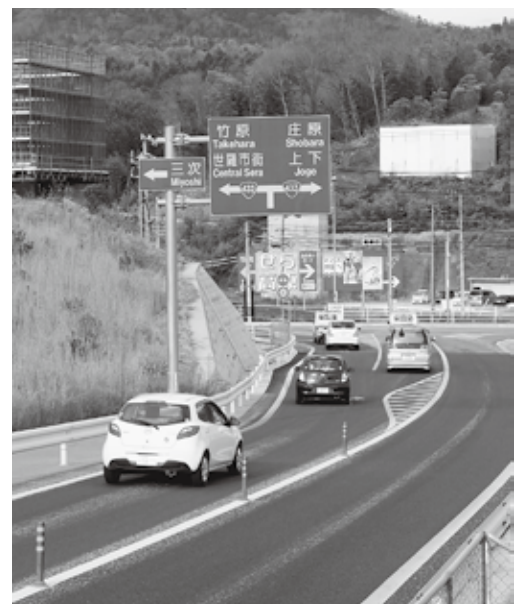
尾道松江線完成後は
