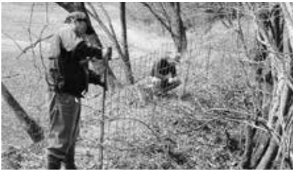
イノシシ防止柵設置
