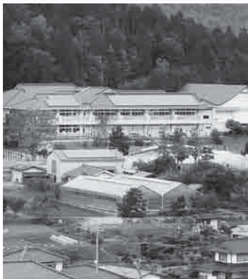
大屋根に設置されたソーラーパネル
