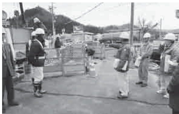
川口地区下水道工事現地調査
