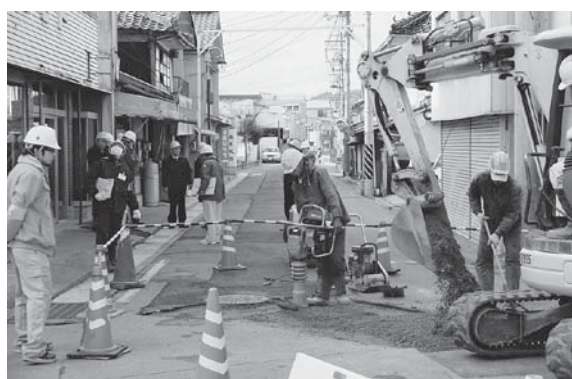
出口地区(甲山本通り)の下水道新設工事
