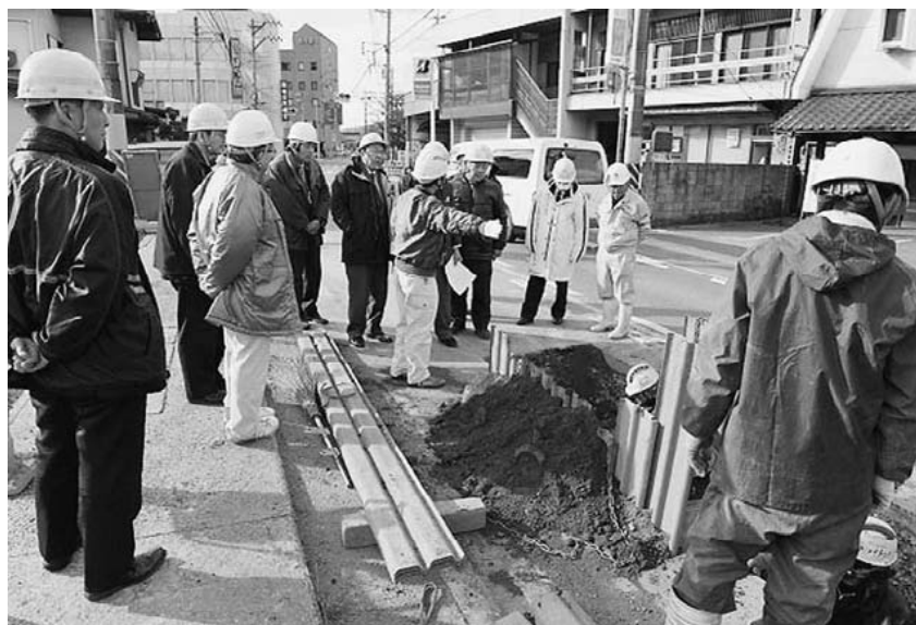
R184 下水道工事現地調査
