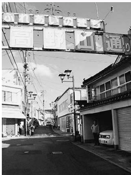
側溝改修が望まれる本通り
