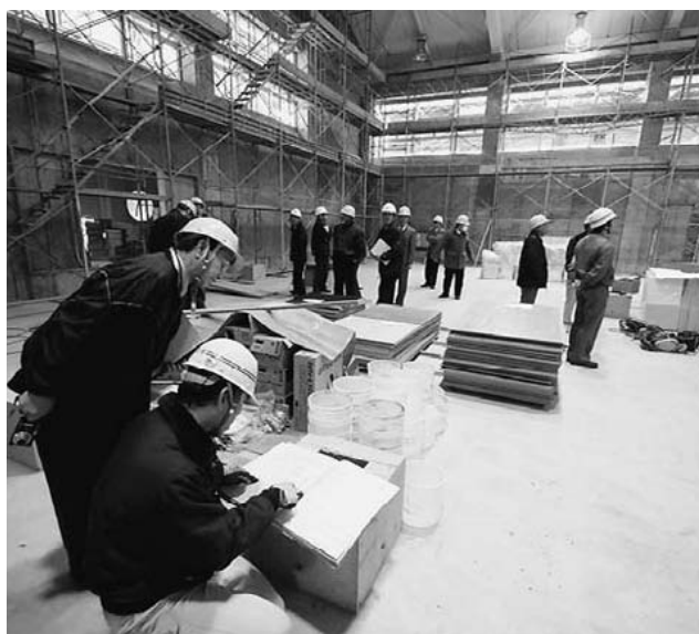
甲山小学校屋内運動場工事を視察
