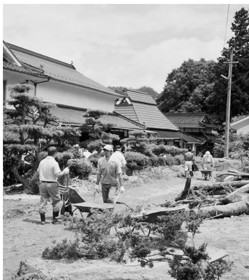
ボランティアによる復旧作業
