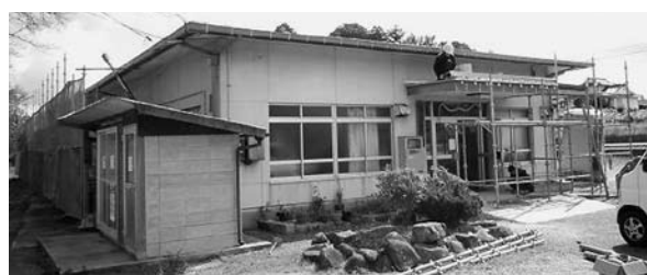
事業で改修される津口創作館
