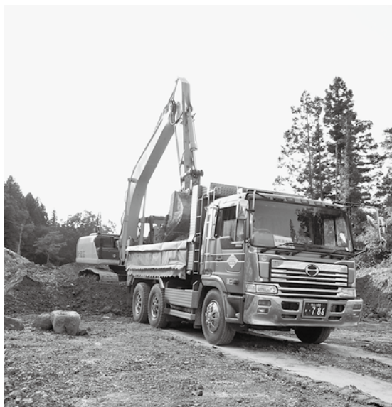
工事が進む安田徳市線
