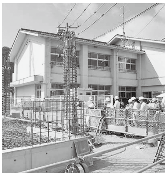
基礎工事中の甲山小学校屋内運動場
