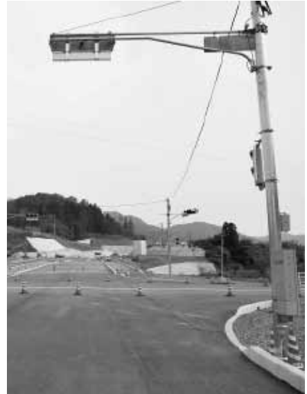
改良工事が進む(仮称)甲山インター付近
