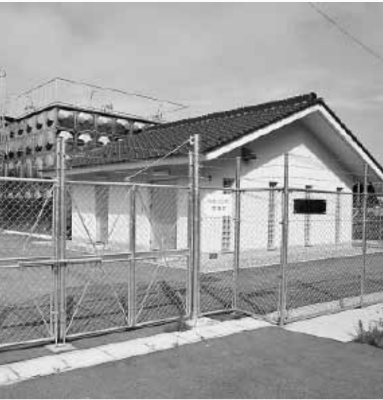
黒川地区 配水池
