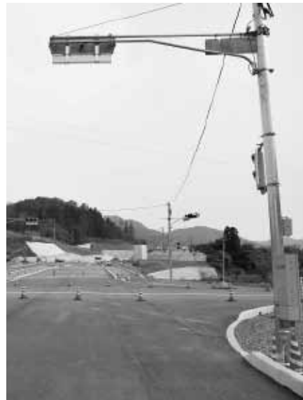
改良工事が進む(仮称)甲山インター付近
