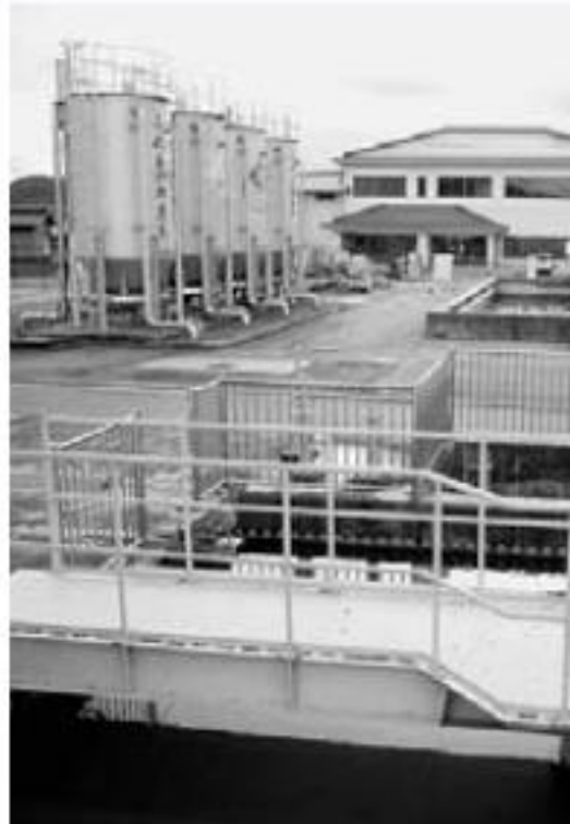
公営企業さかえ浄水場
