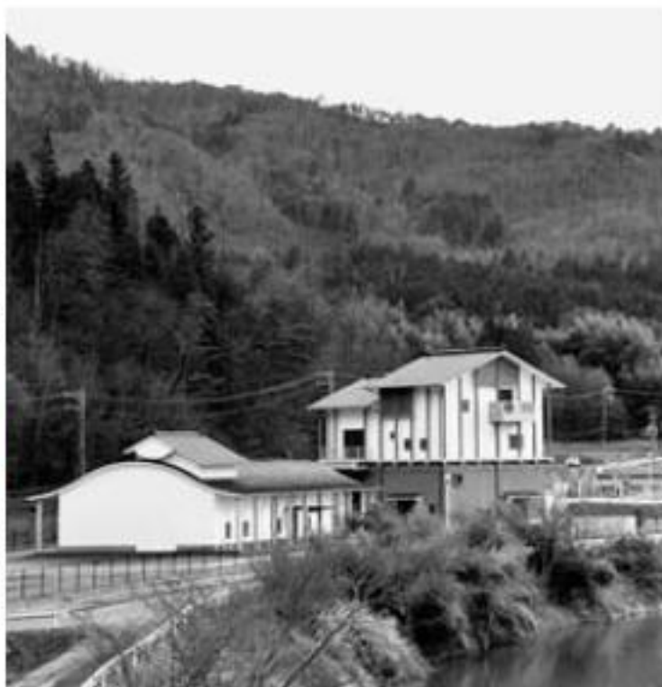
公共下水道アクアステーション
