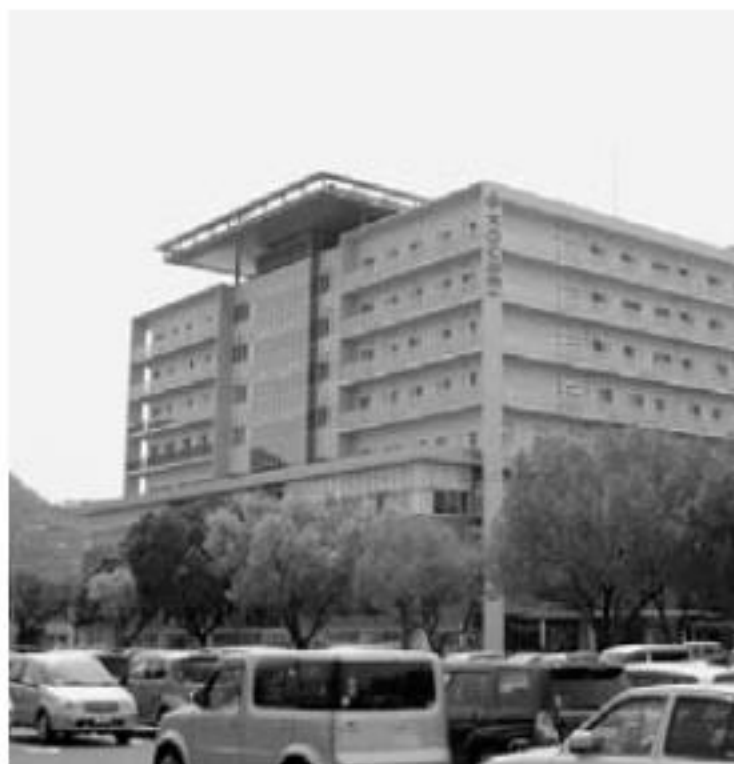
新設された三原興生病院の屋上ヘリポート
