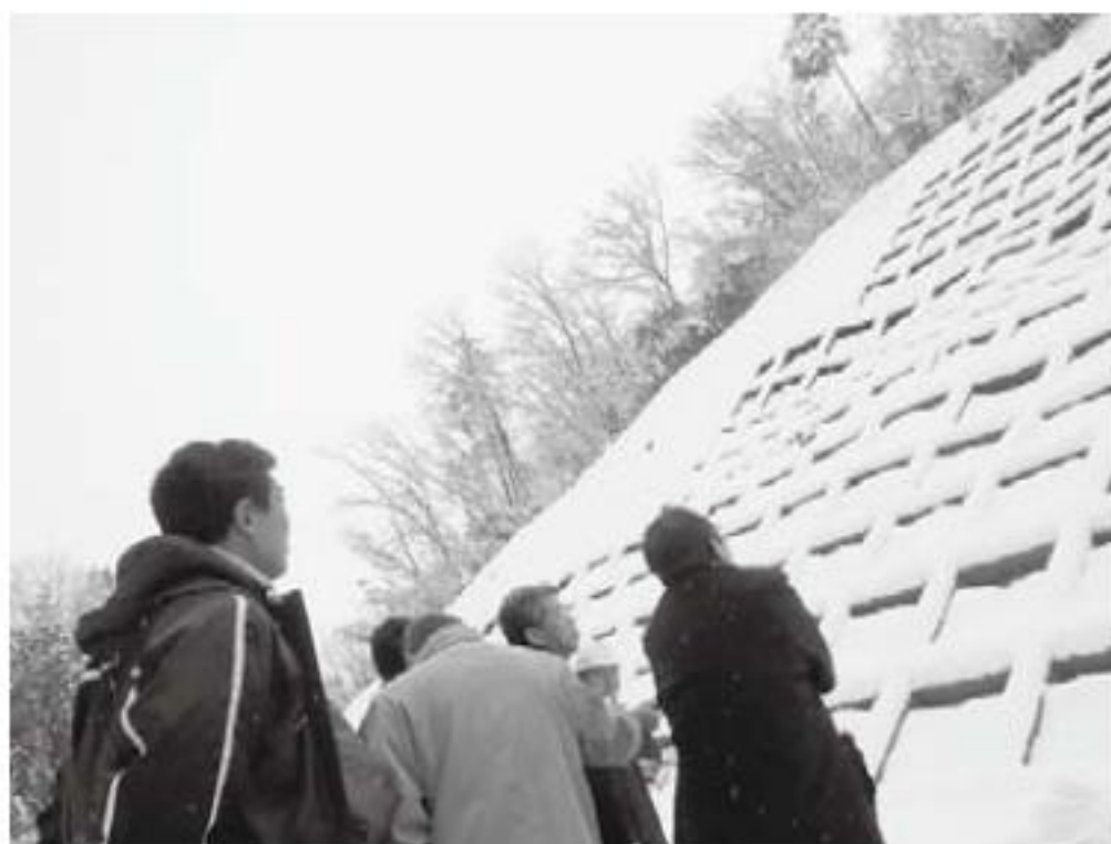
アップルロード災害復旧現場を視察
