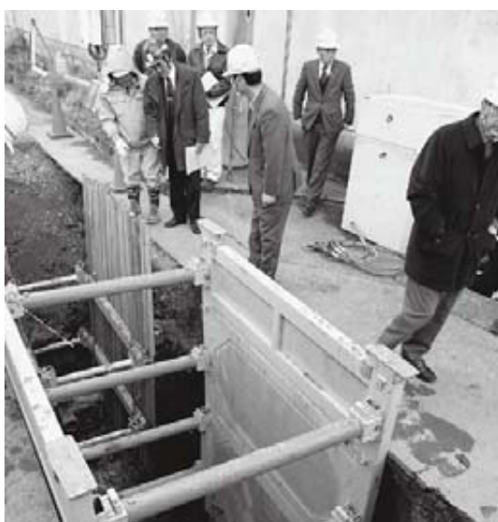
下水道工事現地調査（西上原地区）
