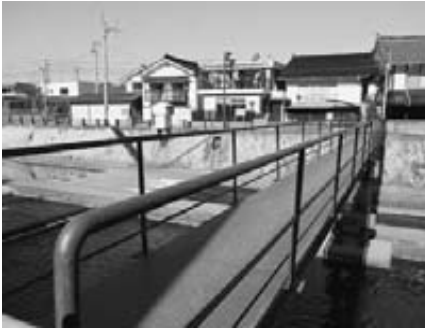
再塗装された橋
