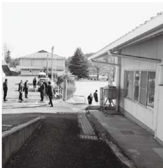
移転を望む黒川自治センター（旧小学校特別教室）
