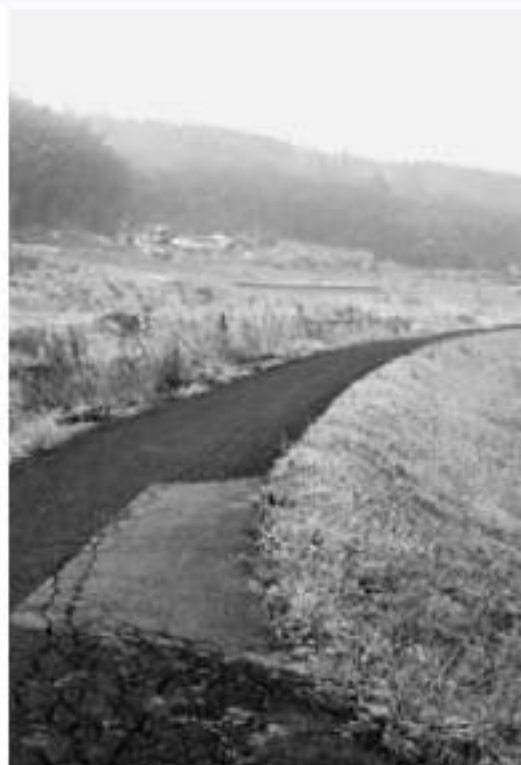
町道河川敷の管理は？
