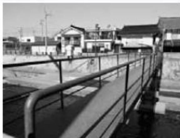
再塗装された橋
