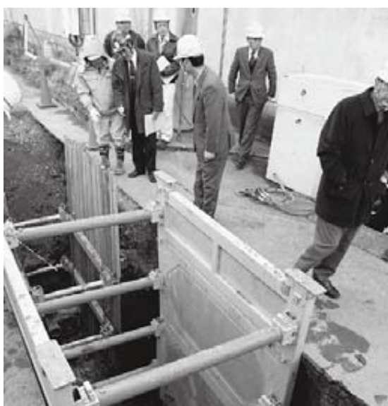
下水道工事現地調査（西上原地区）
