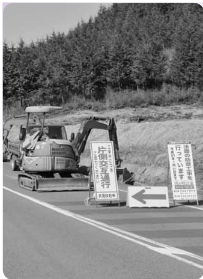
防草コンクリート工事
