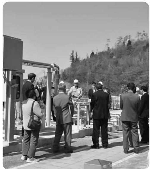
供用開始された下水処理場
