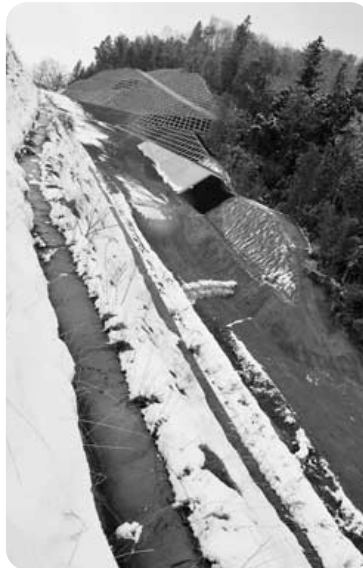
町道安田徳市線工事
