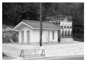
巨額の投資が続く西地区上水道整備
