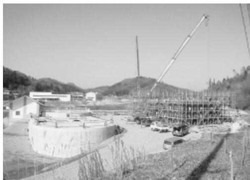
建設中の終末処理場
