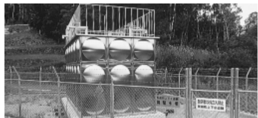
山田川ダムを水源とする青近地区に立地する貯水槽
