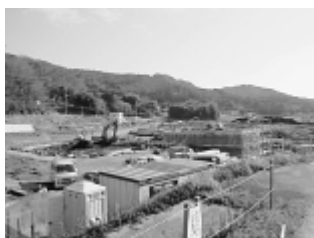
処理場築造中
