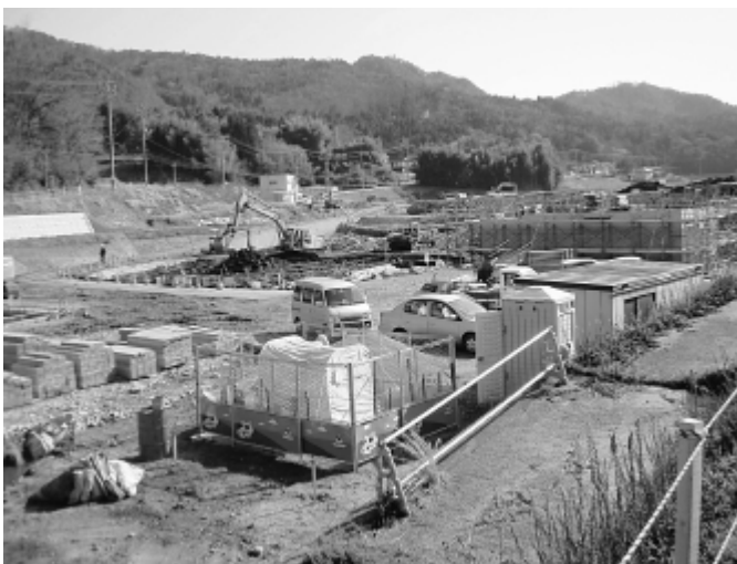
見直しを求めている公共下水道事業 処理場築造中
