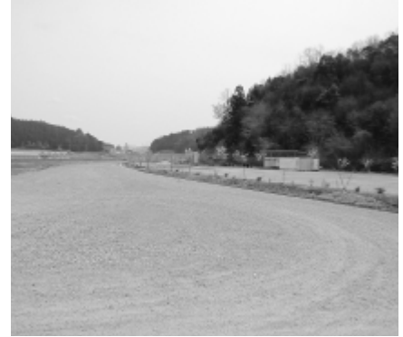
舗装施工の陳情がされている、町道奈良之木中原線
