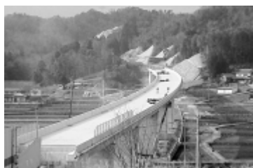
完成した宇津戸川橋梁部分
