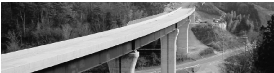
川尻地区の第2陸橋
