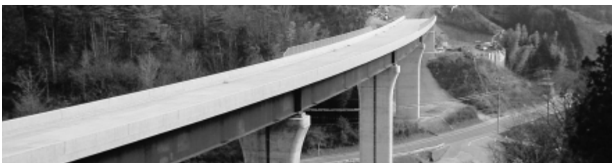
川尻地区の第2陸橋
