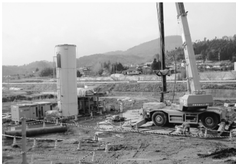
財政ピンチのなかで、建設に着手する処理場
