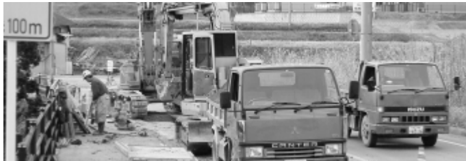
工事だけは、着々と進む下水道支線
