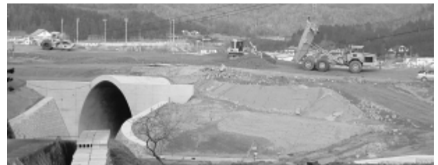
川尻インター付近
