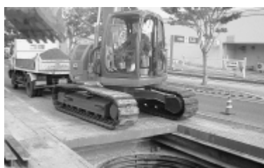
進む下水道工事
