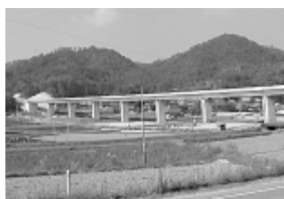
舗装工事を待つのみ 宇津戸川橋梁工事
