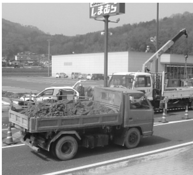
工事中の公共下水道事業
