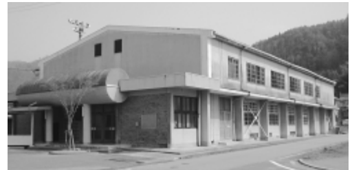
整備を急ぎたい甲山小体育館
