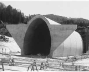
石丸谷地区をつなぐカルバート
