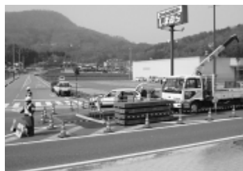
着々と進む公共下水道
