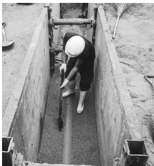
下水道工事中
