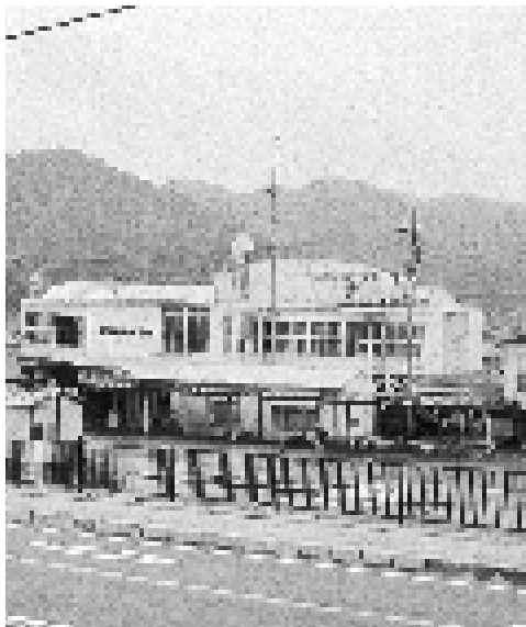
跡地対策に悩む旧世羅町庁舎
